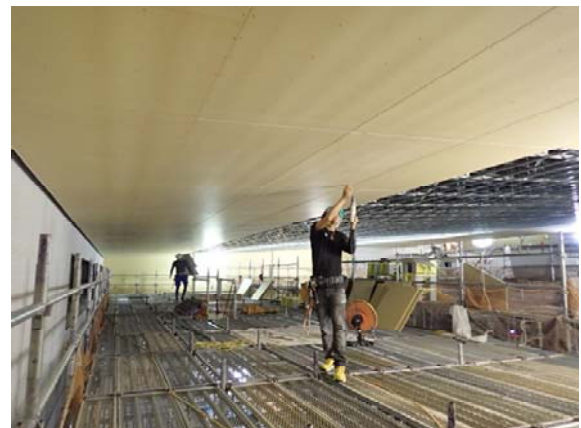
ホール天井ボード貼り状況
