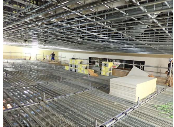
耐震補強天井下地
