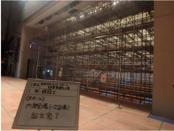
ホール客席仮設足場組立状況
